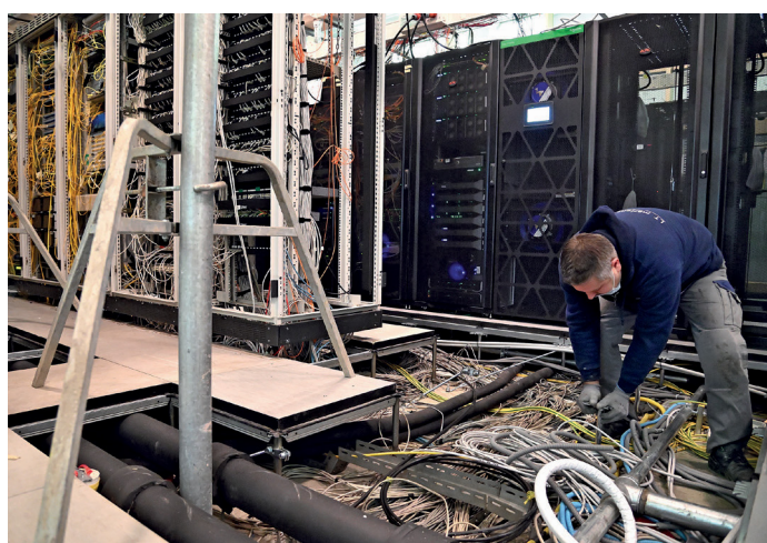
Izvođenje radova uređenja i opremanja podatkovnog centra HR-ZOO ZG1 na lokaciji sjedišta Srca (Marohničeva) u Zagrebu
