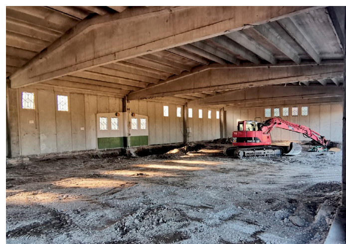
Izvođenje radova uređenja i opremanja podatkovnog centra HR-ZOO ZG2 u sklopu Znanstveno-učilišnog kampusa Borongaj Sveučilišta u Zagrebu
